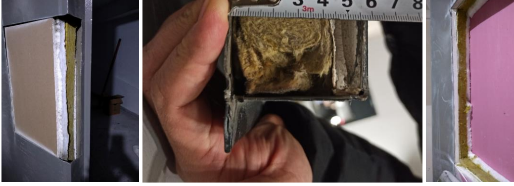
Şekil 3: Kapı kasasının içerisindeki yalıtım ürünleri örnekleri
