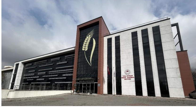
Şekil 1. Tarla Bitkileri Merkez Araştırma Enstitüsü Müdürlüğü Hububat Referans Materyal Merkez Binası
