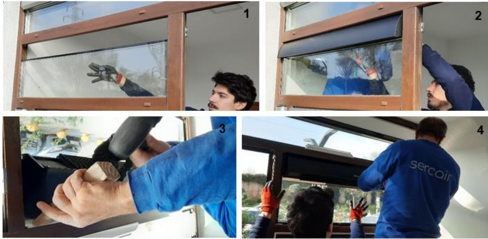
Şekil 6: Cihazın pencerelere montaj aşamaları
