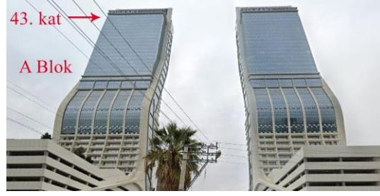
Şekil 1. Çalışmanın yapıldığı çok katlı yapı (A Blok 43. Kat) [31]
