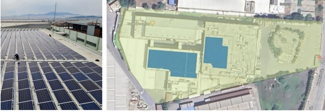
Fotoğraf 4 (a) ve (b): Fabrika çatısında yer alan fotovoltaik panel sistemleri (mavi) [13] [15].
